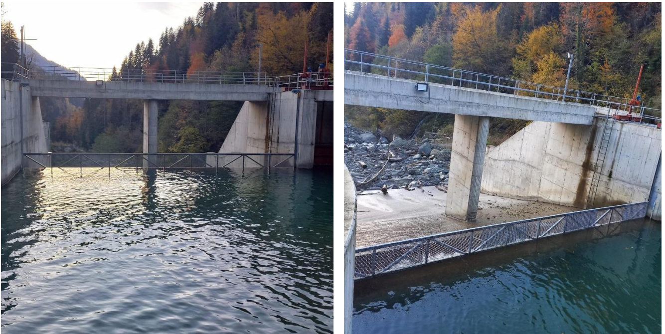
სურ. 5.2.1.1 -წყალმიმღებზე მოსაწყობი თევზამრიდის ნიმუშები
